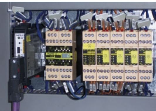
Abb. 2: Die Sicherheits-SPS Pluto AS-i mit Profibus DP Gateway (links) und mehreren Erweiterungsrelais BT51 reduziert spürbar den Verdrahtungsaufwand. (Foto: Jokab Safety)
