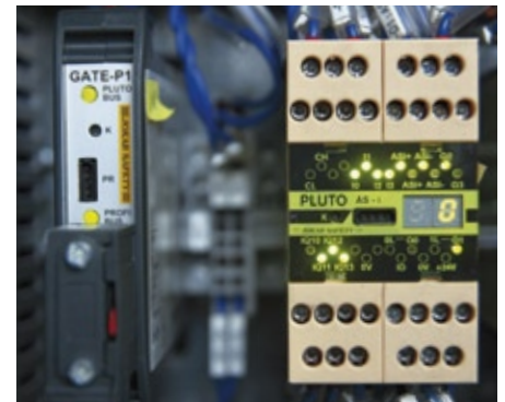
Abb. 2: Das Pluto-AS-i Modul vereint die Funktionen des AS-i-Masters und AS-i-Sicherheitsmonitors und kann bis zu 31 sichere oder nicht-sichere Knoten überwachen. Links ein Profibus DP Gateway. (Foto: Jokab Safety)
