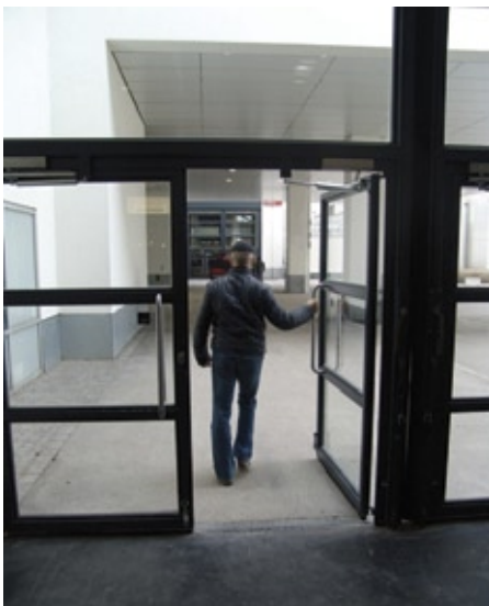
Kein erhöhter Kraftaufwand, da sich der Türöffnungsbegrenzer erst „einschaltet“, wenn die Geschwindigkeit zu hoch wird
