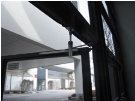
Türöffnungsbegrenzer kontrollieren unauffällig die Türbewegung über den gesamten Öffnungsweg
