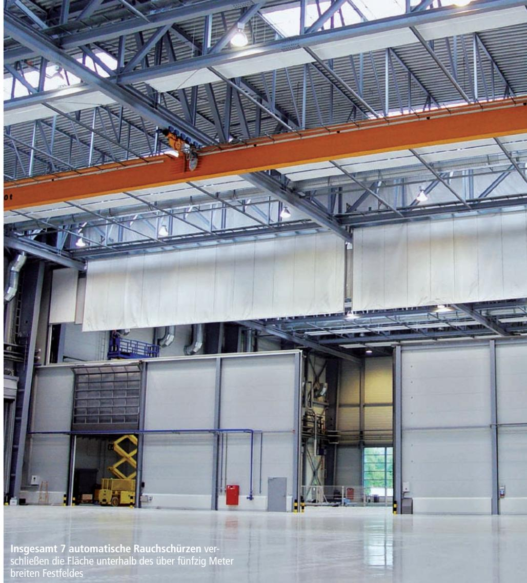
Insgesamt 7 automatische Rauchschürzen verschließen die Fläche unterhalb des über fünfzig Meter breiten Festfeldes
