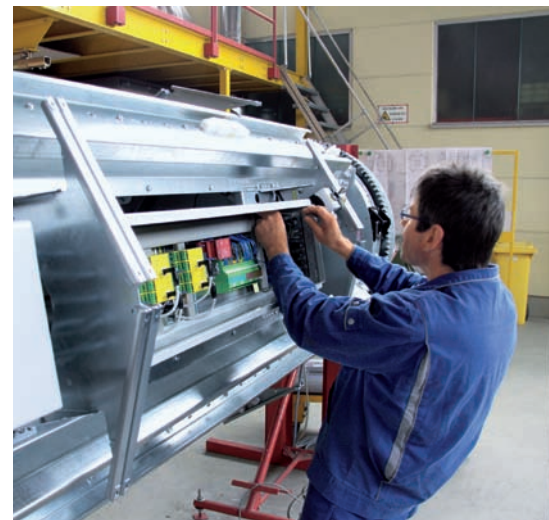
▲ Fertigstellung eines Towers in den Produktionshallen der Gebr. Heege GmbH
