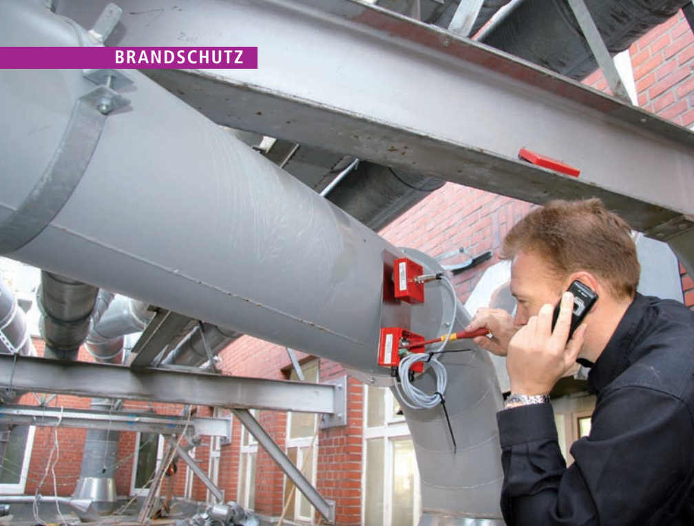
Inbetriebnahme: Ein Mitarbeiter des Kundendienstes nimmt eine Funkenlöschanlage in Betrieb
