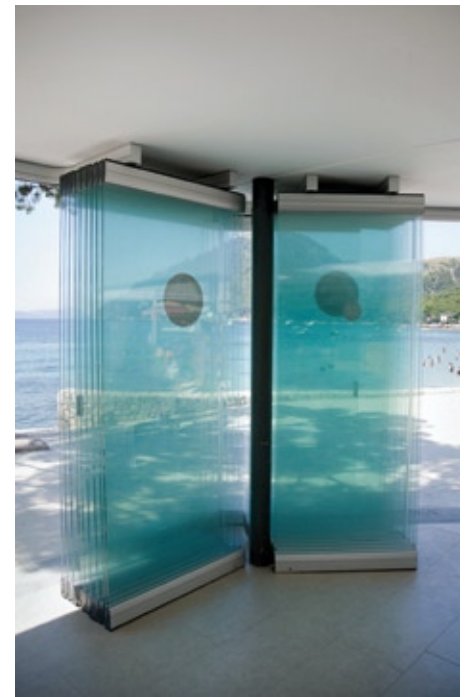
Manuelles Schiebewandsystem von Geze im Hotel Formentor auf Mallorca
