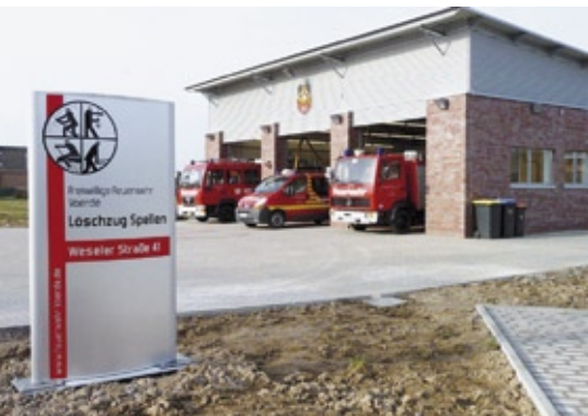
Die neue Fahrzeughalle der Freiwilligen Feuerwehr Voerde Ortsteil Spellen
