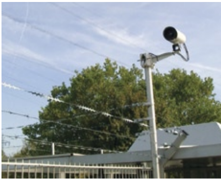
Die Wärmebildkamera FLIR SR 324 überwacht diese ganze Umzäunung.
