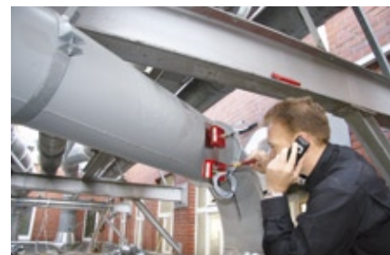
Inbetriebnahme: Ein Mitarbeiter des Kundendienstes nimmt eine Funkenlöschanlage in Betrieb.
