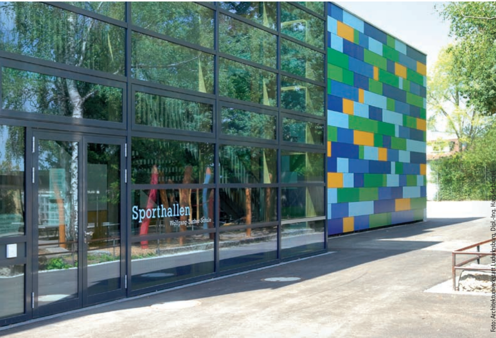
Attraktiver Schulstandort: die Zacher-Schule in Waiblingen wurde umfassend saniert – und sicherheitstechnisch auf modernsten Stand aufgerüstet
