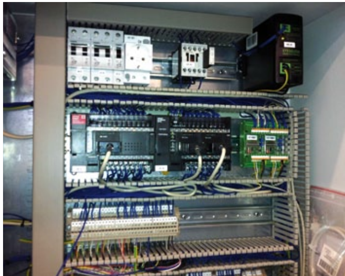
◀ Abb. 2: Sicherheitscontroller (links) und Maschinensteuerung (rechts) arbeiten perfekt zusammen. Beide überzeugen durch ein günstiges Preis-/Leistungsverhältnis
