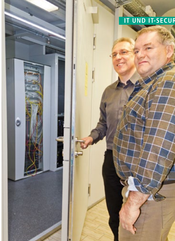
IT-Leiter und Sicherheitsbeauftragter geben Einblick in das Rechenzentrum der Karl Kufner KG.
