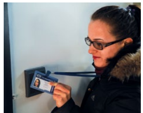
Der Zugang zu Sperrzonen wird über Nedap-Lesegeräte Convexs Mifare kontrolliert.
