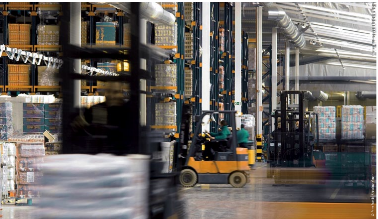
▲ Brandfrühsterkennung mit „Ansaugrauchmelder SecuriRAS ASD 535“ im Hochregallager
