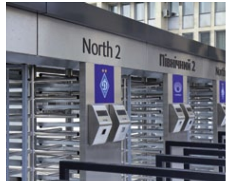
Drehkreuze mit integrierten Ticketlesegeräten an den Eingängen
