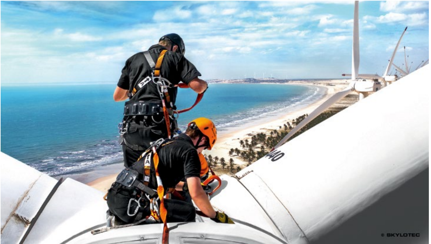
Persönliche Schutzausrüstung und Absturzsicherung von Skylootec sorgen für Sicherheit – auch für Arbeiten an Windkraftträgern
