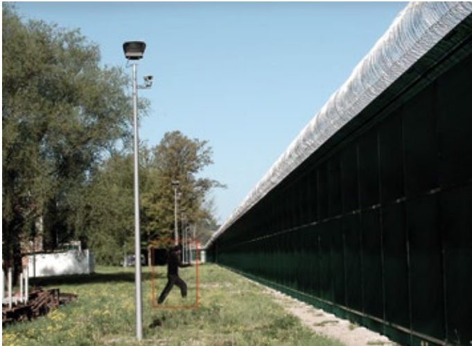
„IPS Outdoor Detection“ – intelligentes Videoanalyse-Modul für die Echtzeit-Alarmierung bei Eindringen in gesicherte Außenbereiche
