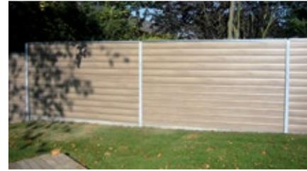
ralwolle erreicht die Lärmschutzwand eine Schallreduzierung um 27 dB und verringert zusätzlich auch Strömungsflüsse und Windgeschwindigkeiten. [info@vegasonic.de](mailto:info@vegasonic.de)
