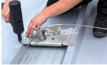
oder einer Akku-Nietpistole vernietet. Durch die wasserdichten Blindnieten und die aus einem speziellen EPDM-Moosgummi vormontierten Dichtstreifen ist die Dachhaut an der Befestigungsstelle sofort abgedichtet. Der Aufwand für Abdichtungsmaßnahmen fällt weg. [www.absturzversicherung.de](http://www.absturzversicherung.de)
