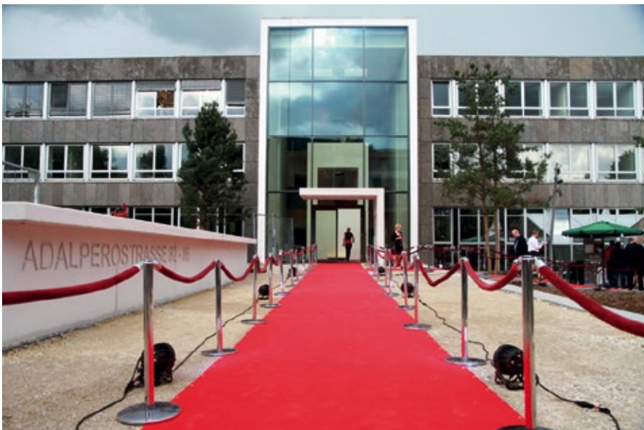
Das neue Bürogebäude in der Adalperstraße 86
