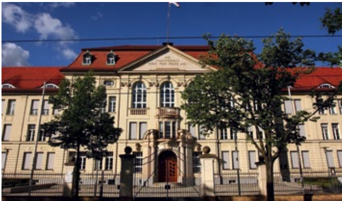
Siemens hat die Sicherheitstechnik am Regierungsstandort Potsdam – unter anderem in der Staatskanzlei – modernisiert.
