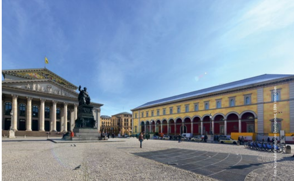
Münchener Vorzeigeprojekt Palais an der Oper setzt auf Sicherheit von Bosch
