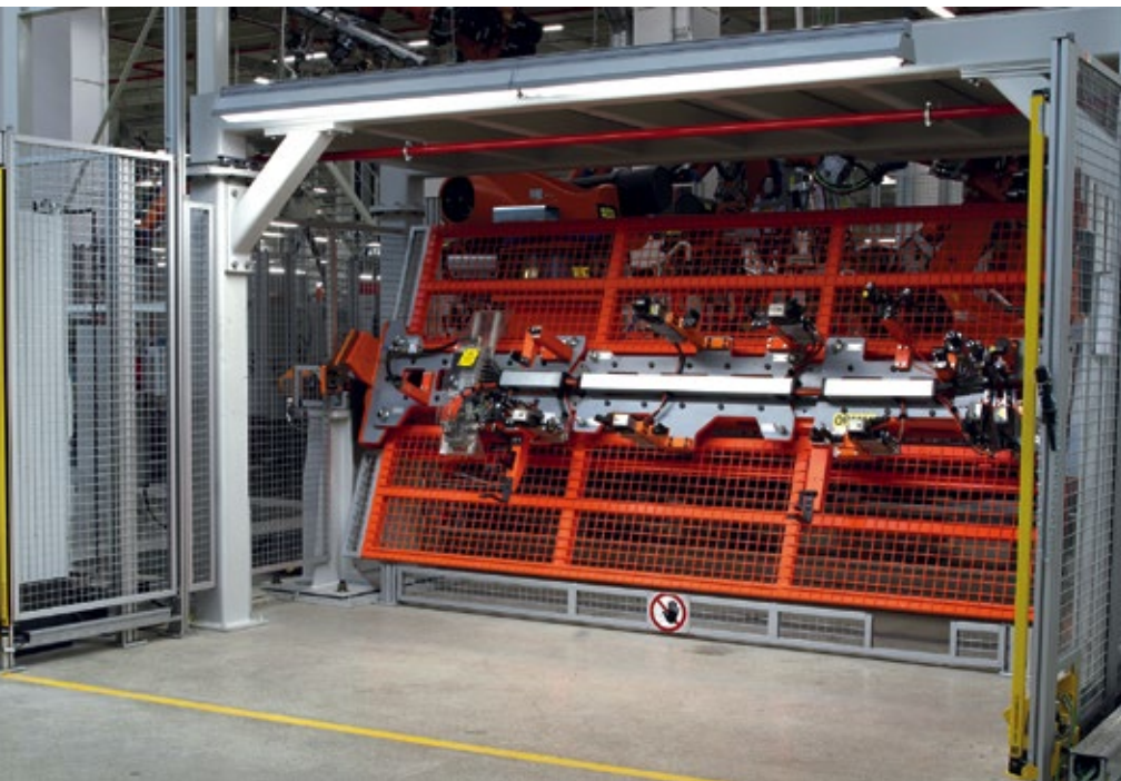
Abgesicherter Hand-Einlegeplatz im Karosseriebau für den neuen Audi A3 im Ingolstädter Audi-Werk
