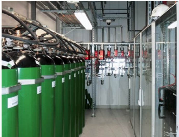
◀ Insgesamt 400 kg Stickstoff werden zur Schnellabsenkung im Ereignisfall bereitgehalten
