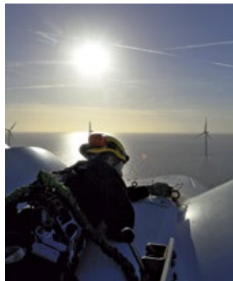
Für die Feuerwehr wie Reparatur-Teams sehr schwer zu erreichen, aber jetzt schnell zu löschen: Windkraftgeneratoren
