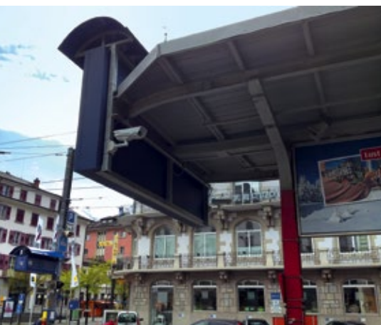
Eine Axis P 1344 E im Einsatz am Bahnhof Brig
