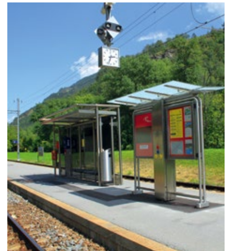
Fahrgastinformation, Sprachinformation und Videoüberwachung kombiniert an einer Station
