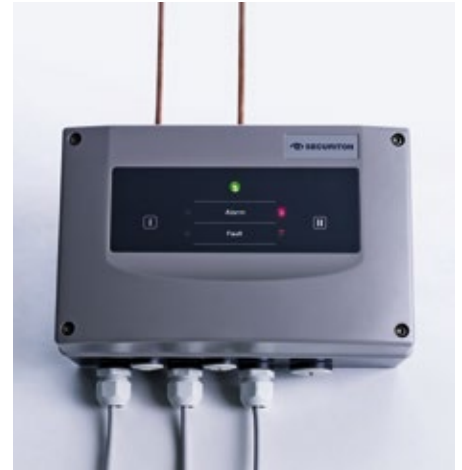
Überall, wo es drauf ankommt – die neue Auswerteeinheit des SecuriSens ADW 535
