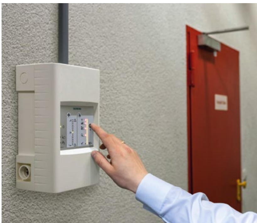
Die neuen Ansaugrauchmelder wurden für herausfordernde und sensible Detektionsbedingungen entwickelt
