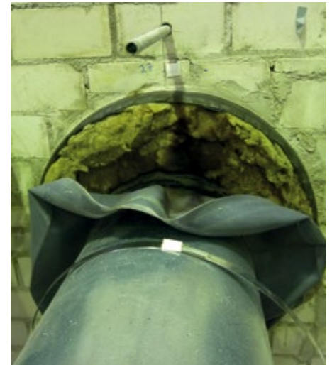
Nach dem Brandversuch vom 11.04.2012: die Mineralwollestopfung weist keine Sinterungserscheinungen auf
