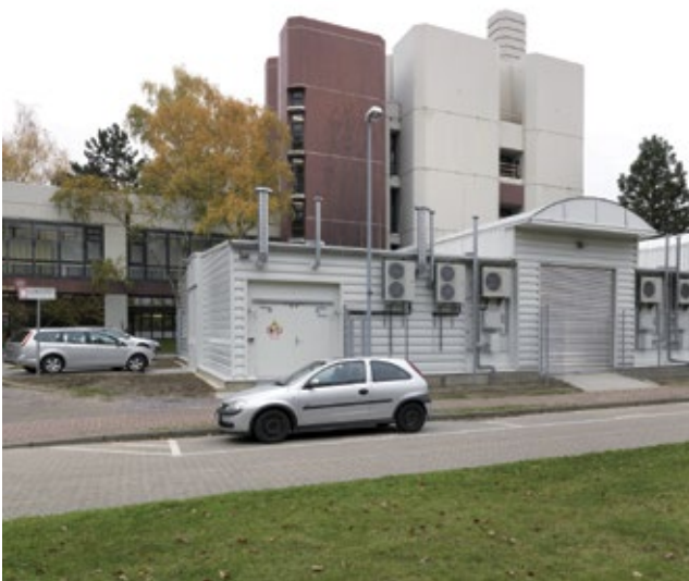
Zentrales Interims-Gefahrstofflager bestehend aus 17 Brandschutzcontainern
