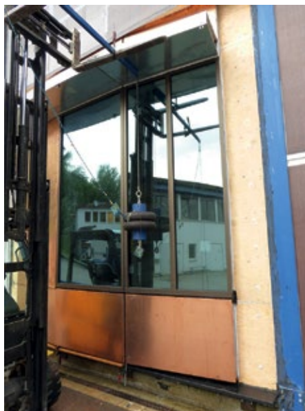
Elementfassade bei Prüfung Stoßfestigkeit
