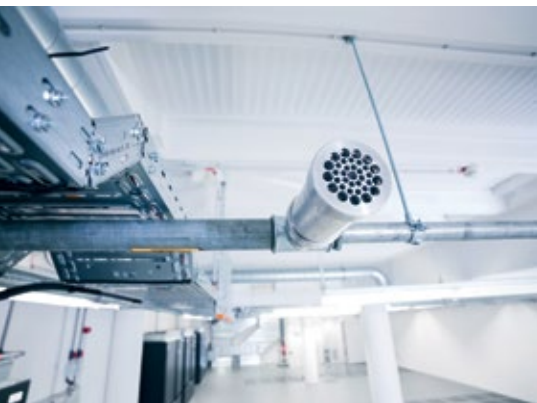
Schutz für das geräuschempfindliche IT-Equipment: Mit den speziell für den IT-Bereich entwickelten Silent-Düsen verringert sich beim Auslösen der Gaslöschanlage der Schalldruckpegel von etwa 130 auf 98 dB(A)
