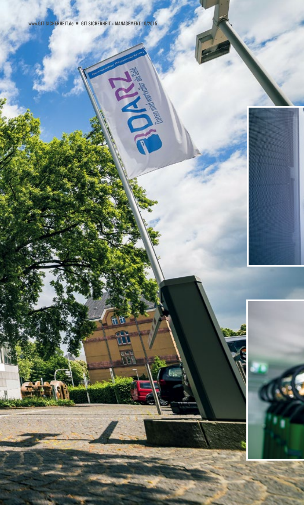
◀ Das neue Rechenzentrum von DARZ ist im ehemaligen Gebäude der hessischen Landesbank in Darmstadt untergebracht
