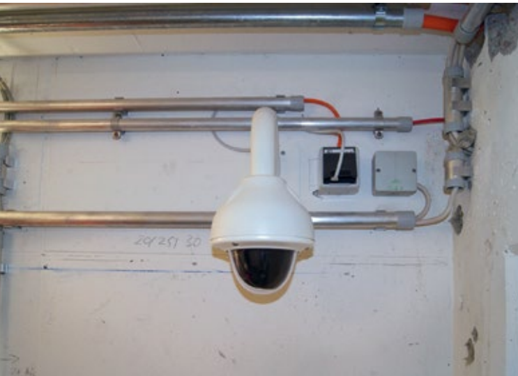
Kamera mit Vandalismus-schutz im Handbereich mit gepatchter Stecker-Verbindung
