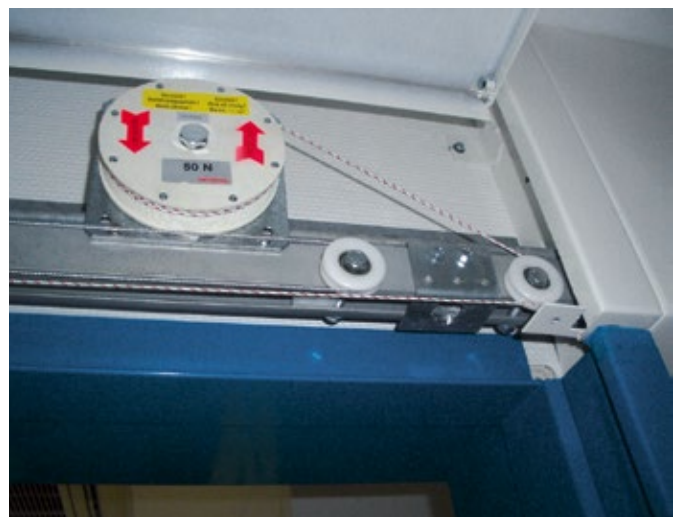
▲ Der Schließmechanismus verschwindet hinter der Abdeckung
