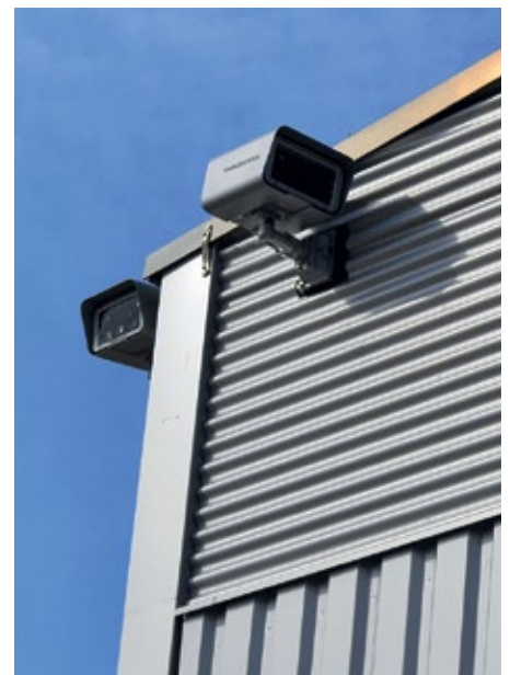
Die Multifocal-Sensortechnologie Panomera von Dallmeier arbeitet mit mehreren Objektiven – so kann ein großes Areal von nur einem Standort aus in höchster Detailauflösung überblickt werden
