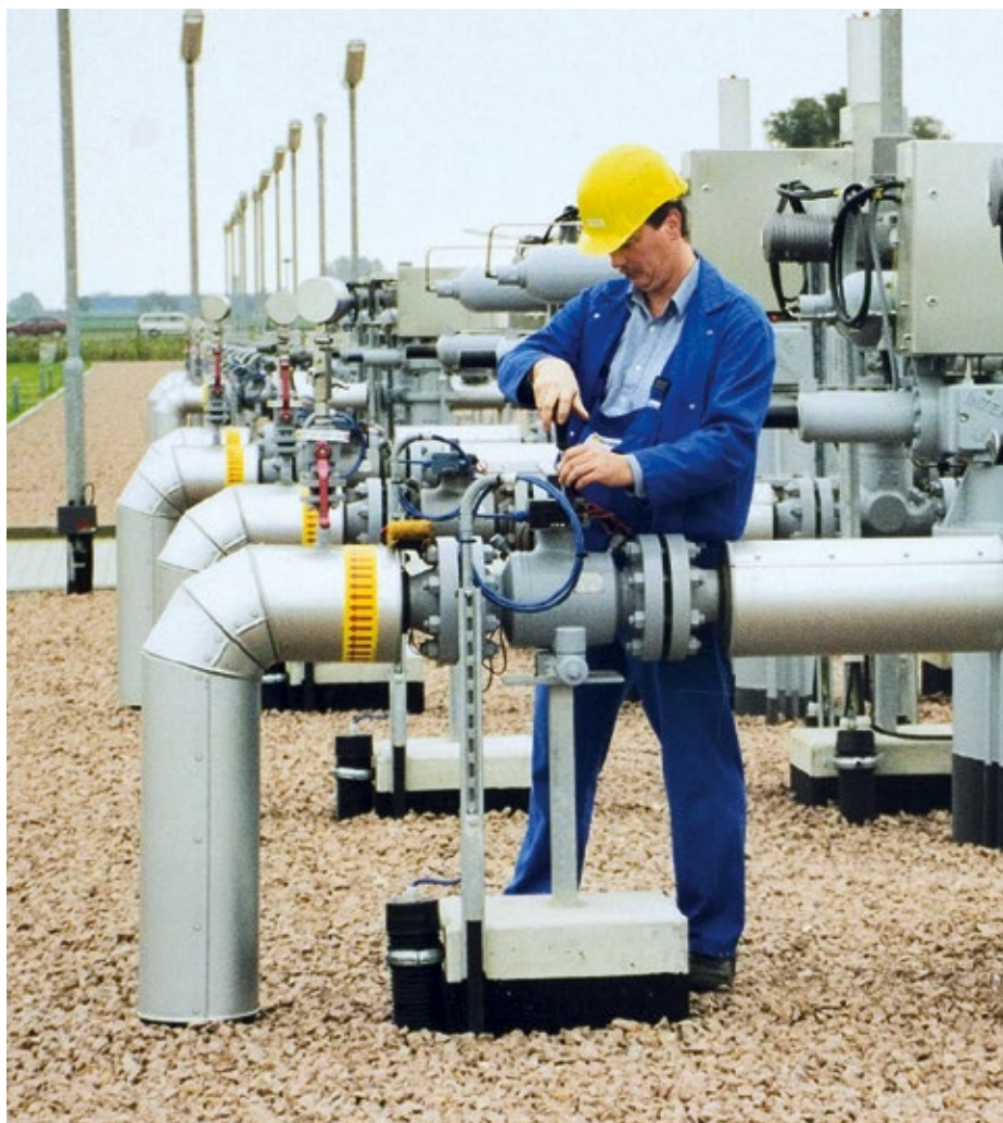
Wartungsarbeiten auf der Ontras-Verdichterstation Bobbau ▲
