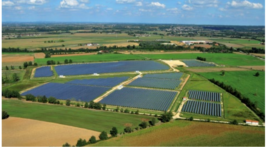
Die Solarstromanlage in Ternavasso, Italien
