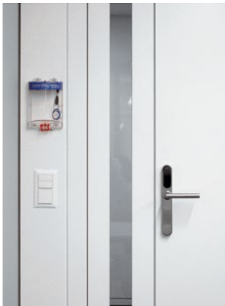
Elektronische AMOK-Lösung an einer Seminarraumtür der PH Zürich
