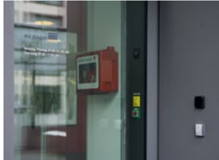
XS4 Online-Wandleser an einem Ausseneingang der PH Zürich. Die Wandleser steuern den Zutritt, übertragen aktualisierte Zutrittsrechte auf die Karten und lesen die Batteriestände der benutzten Türeinheiten von den Karten
