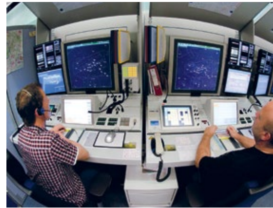
Zwei von ca. 120 Arbeitsplätzen im Control Center Langen
