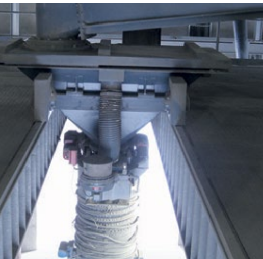
Vorher/Nachher-Aufnahme bei HeidelbergCement
