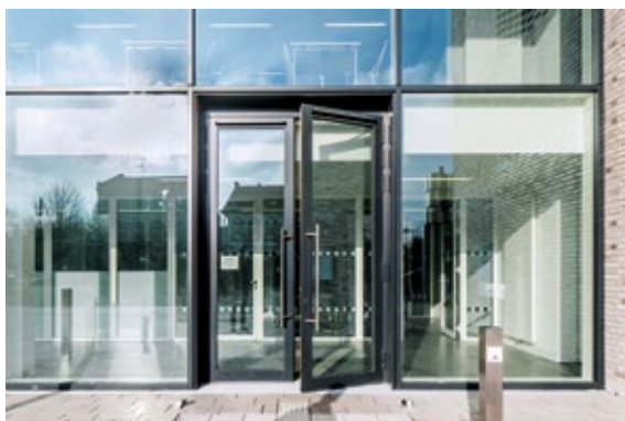
▲ Türautomatik von Geze am Haupteingang des neuen Justizzentrums: Drei zweiflügelige automatische Drehtüranlagen mit den preisgekrönten Powerturn-Antriebssystemen des Herstellers sorgen für barrierefreien Türkomfort
