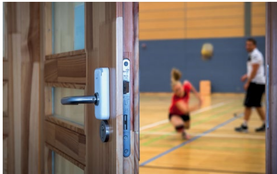
▲ Elektronischer Kurzbeschlag XS4 Mini an einer Turnhallentür im Bundesleistungszentrum Kienbaum. Der XS4 Mini ermöglicht die Anbringung eines plan versenkten Türdrückers auf der Innenseite der Tür, um den vorgeschriebenen Unfallschutz einzuhalten
