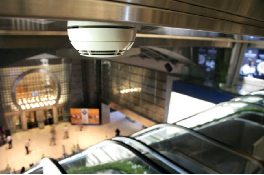
Gebäude haben vielfach auch infrastrukturelevante Funktionen oder beherbergen eine große Anzahl an Menschen. Um optimale Ergebnisse zu erreichen, ist eine isolierte Betrachtung der einzelnen Gewerke nicht mehr zielführend
