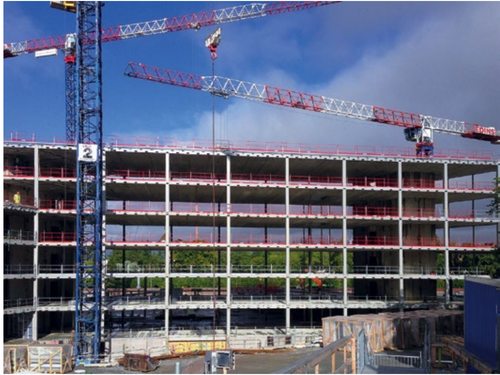
Combisafe kam mit einer innovativen Lösung: dem Einlegen einer Anschweißbefestigung für das System direkt in jeden einzelnen Steinblock vor dem Bau
