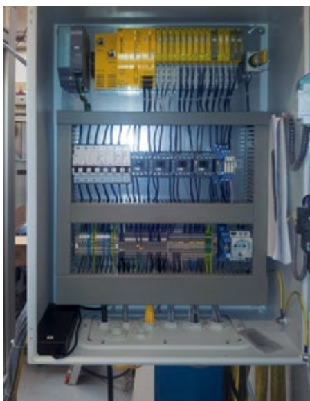
Das Herausragende am Automatisierungssystem PSS 4000 für ATG ist, dass es fehlersichere Prüfgrenzen während des Prüfverlaufs rechnerisch ermitteln und dynamisch anpassen kann
