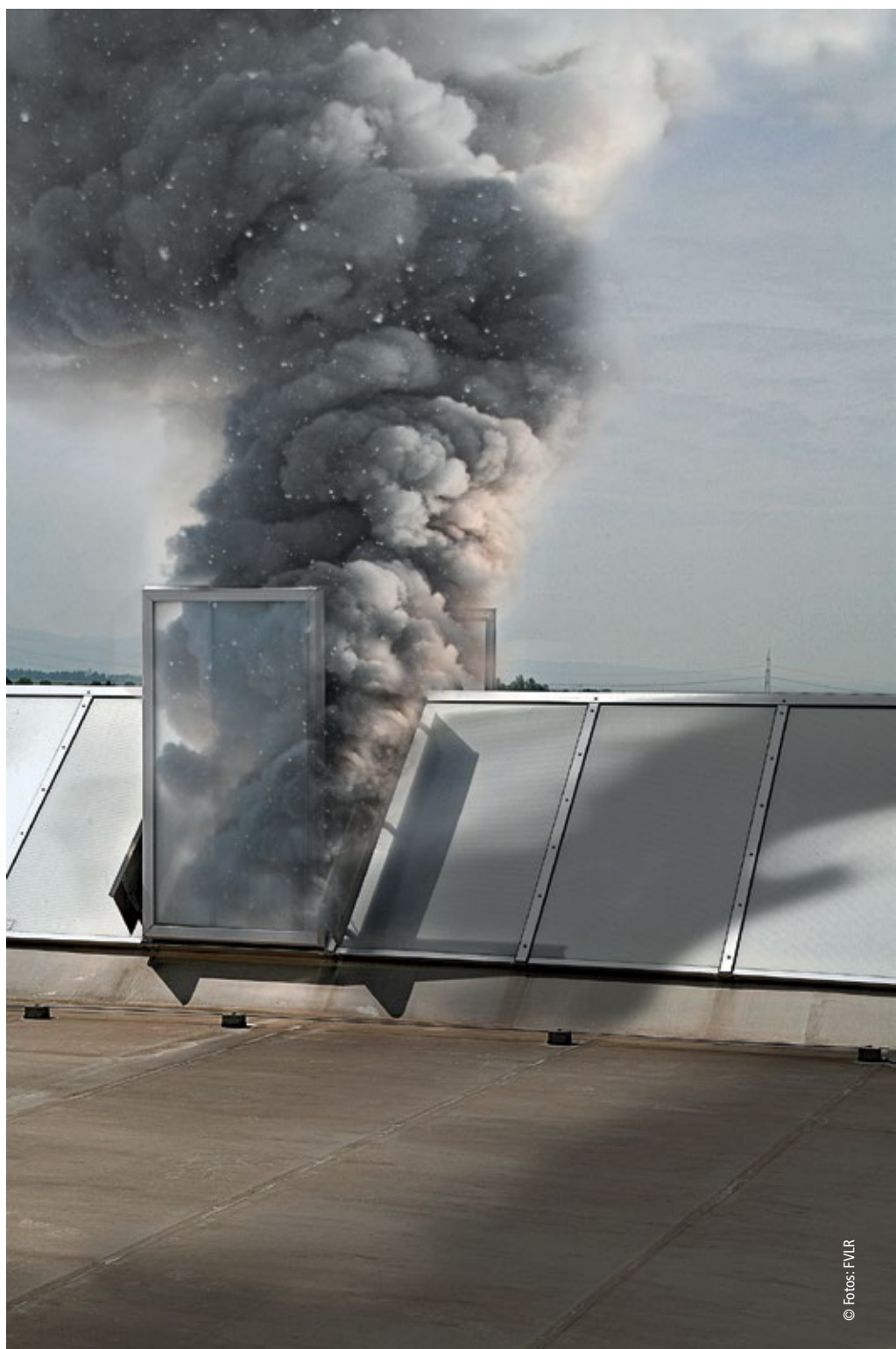
Eine effektive Ableitung des toxischen Brandrauchs kann Menschenleben retten. Quelle: Fachverband Tageslicht und Rauchschutz
