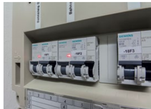
Der Brandschutzschalter 5SM6 von Siemens erkennt zuverlässig gefährliche Fehlerlichtbögen, die durch beschädigte Leitungen entstehen können
