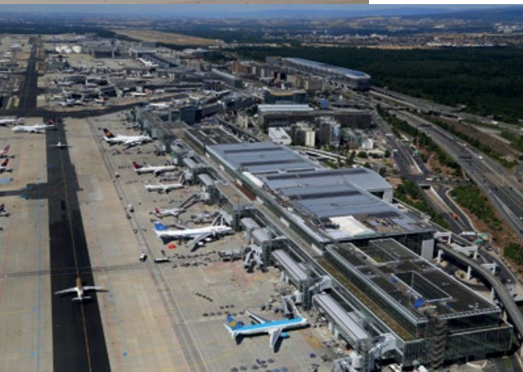
Im Jahr 2022 soll das Terminal 3 am Frankfurter Flughafen fertig sein. Die Baustelle wird mit u.a. mit Dallmeier-Technik gesichert
