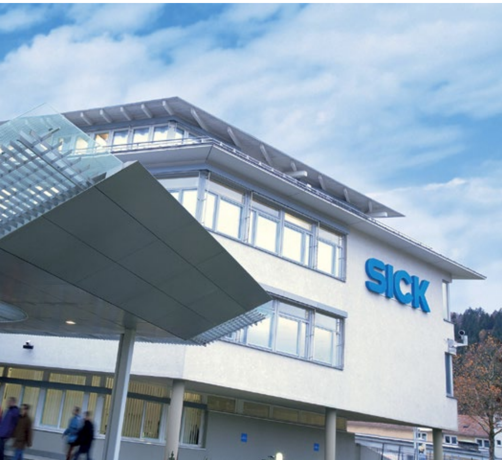
Haupteingang Sick AG in Waldkirch
