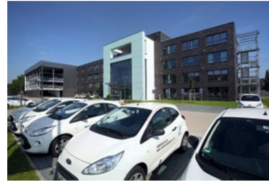
Blick auf das neue, hochfunktionale Firmengebäude und weitreichende Areal der Niedersächsischen Wach- und Schliessgesellschaft/VSU in Hannover
