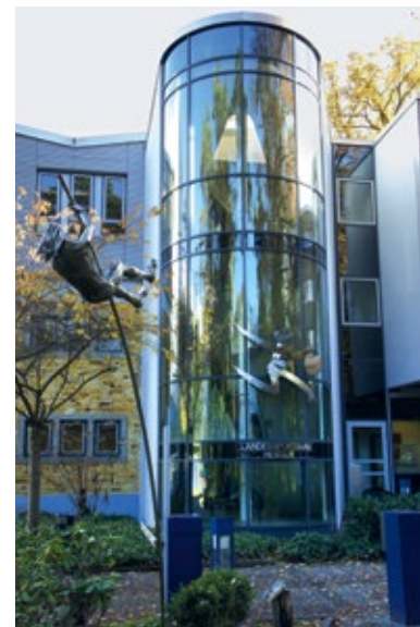
Der Schwimmstützpunkt des Landessportbunds Hessen (LSBH) in Frankfurt am Main nutzt IP-Videotechnik von Mobotix
