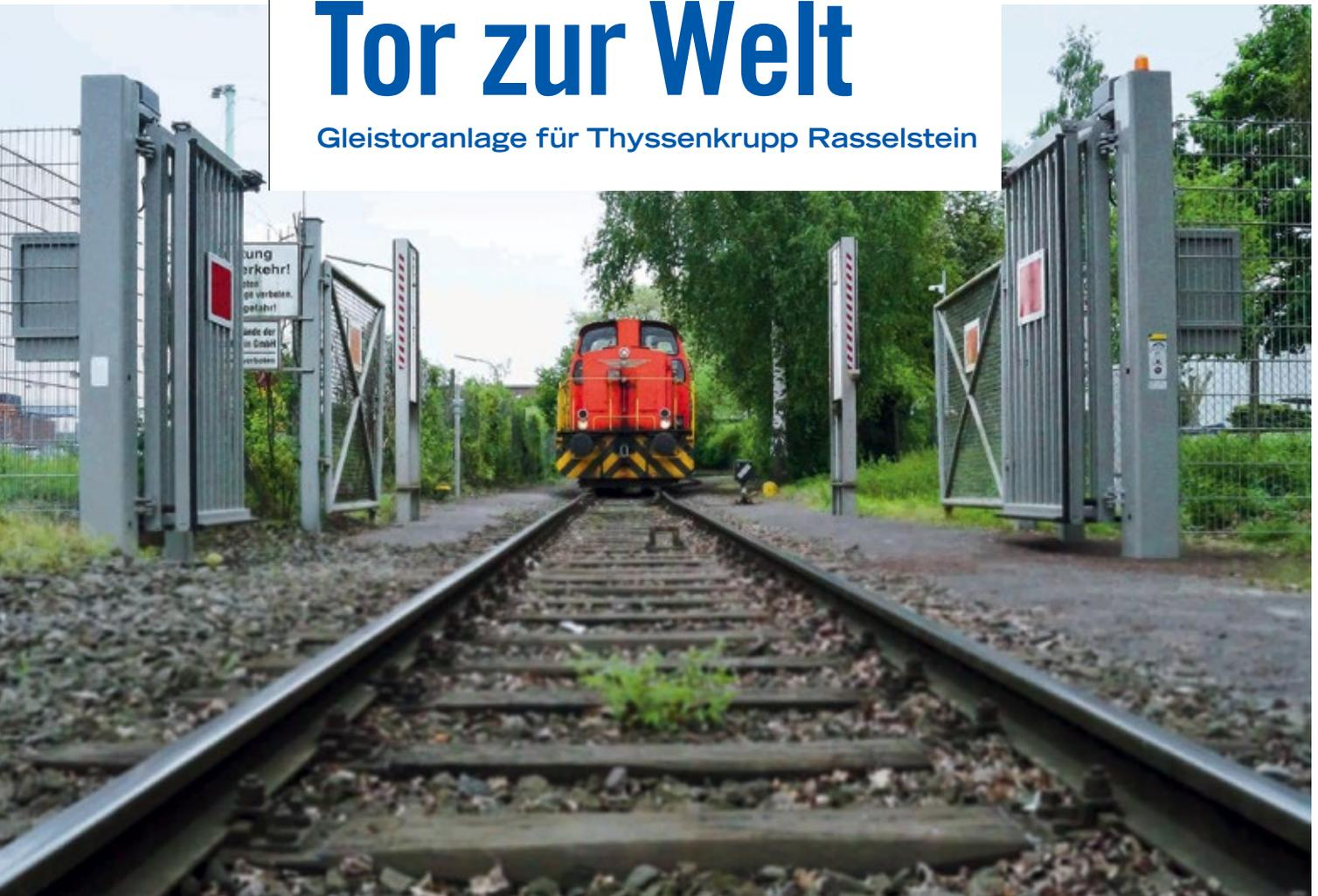
Von hier aus liefert Thyssenkrupp Rasselstein Weißblechprodukte in 80 Länder. Im Bild die Gleistoranlage Entraquick von PPG: Das freitragende Schnelfalttor kommt ohne störende Ober- oder Unterholmführung aus und ermöglicht ein Schließen nach jeder Durchfahrt
