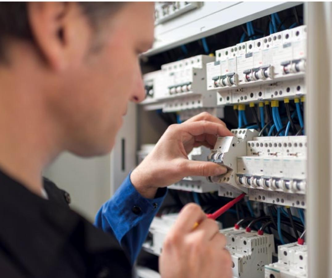
Der Brandschutzschalter lässt sich einfach im Verteiler installieren und ergänzt die bestehenden Schutzschaltgeräte
