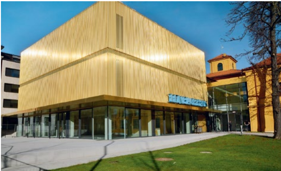
Das Münchener Kunstmuseum Lenbachhaus hat ein Gefahrenmanagementsystem von Wagner installiert
