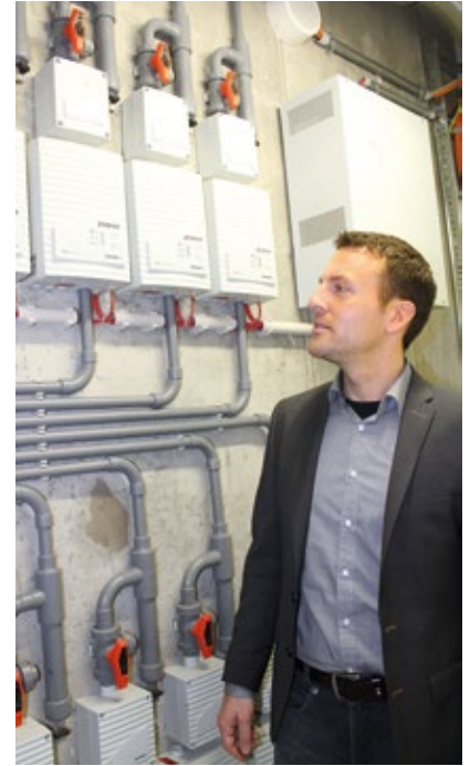
▲ Dennis Just, Technische Leiter der Elbphilharmonie, vertraut auf Brandschutztechnik von Wagner Group – mit den Ansaugrauchmeldern Titanus
