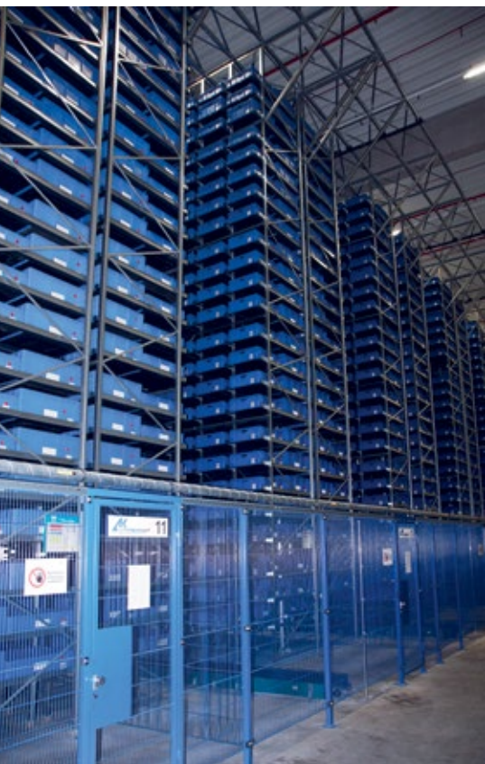
▲ Der Warenfluss darf nicht abreißen – eine zuverlässige Brandschutzlösung ist essentiell
