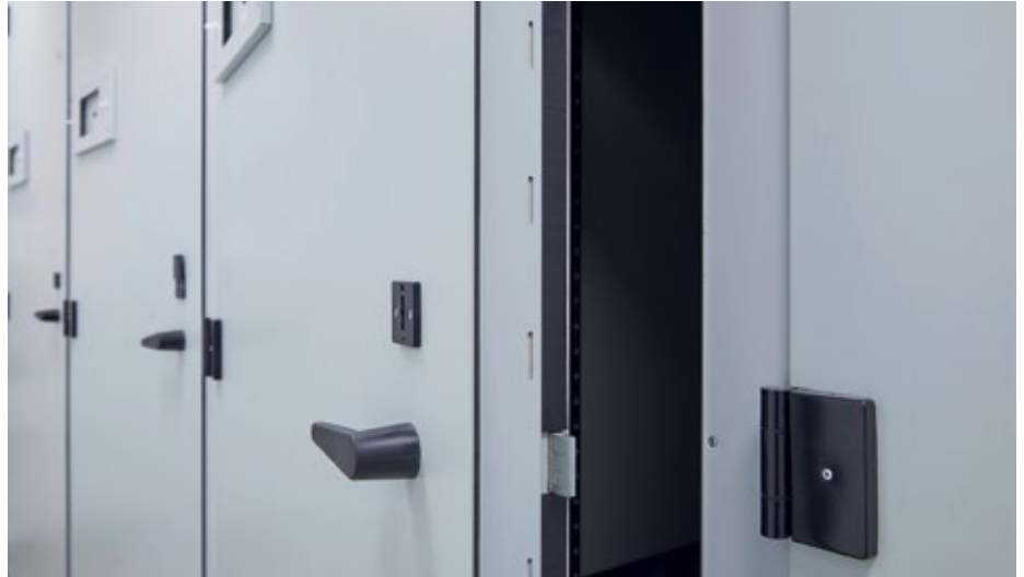
Die Sicherheitsfunktionen des Rittal Micro Data Center sorgen dafür, dass im Fall eines Feuers die garantierten Brandschutzwerte von 90 Minuten nach DIN 4102 (F90) eingehalten werden
