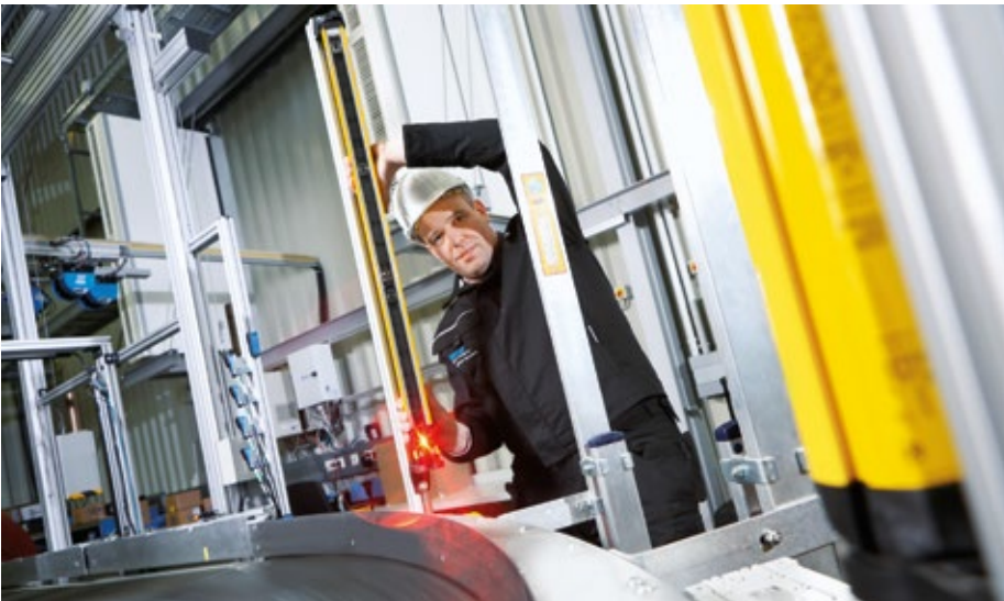
▲ Im Rahmen einer Anlagenbegehung erfolgt eine erste Inaugenscheinnahme von Maschinen und ihrer Sicherheitstechnik
