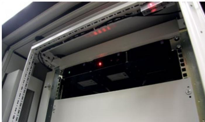
▲ Die DET-AC III von Rittal ermöglicht durch die integrierte CAN-Bus Schnittstelle eine direkte Anbindung an das Monitoring System CMC III
