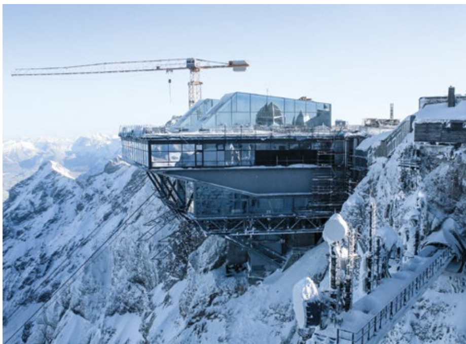
Seit Dezember 2017 in Betrieb: Die neue Zugspitz-Seilbahn
