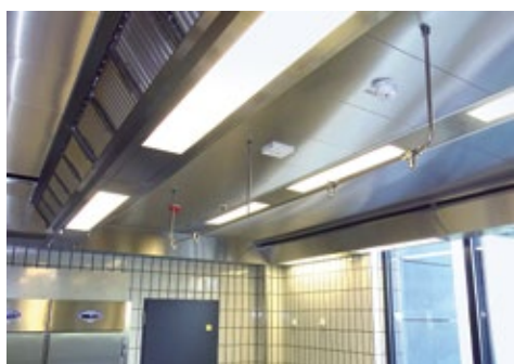
VdS unterstützt Versicherer und Betreiber der besonders brandgefährdeten Gastronomiebranche mit dem kostenlosen Infoblatt VdS 3846 (im Bild eine VdS-anerkannte Küchenschutzeinrichtung der protectfire GmbH), Foto: protectfire GmbH
