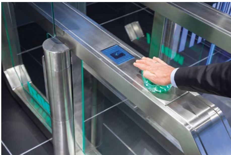
Personenidentifikation mittels Handvenenerkennung, integriert in einer Schleuse zur Zutrittssteuerung
