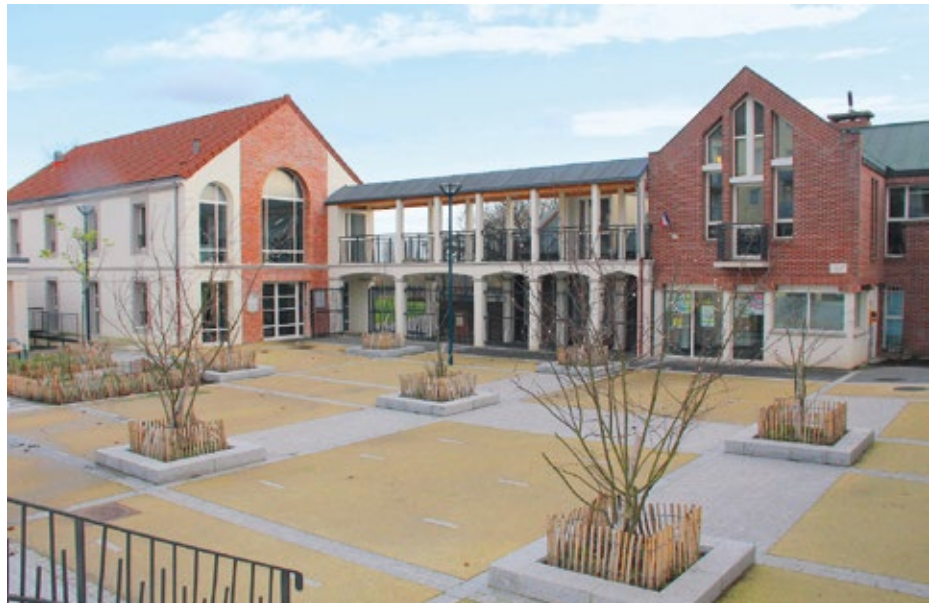
Für 20 städtische Gebäude sorgt Net2 von Paxton für die Zutrittssteuerung – unter anderem die Schule: Das „Maison Jeunesse“
