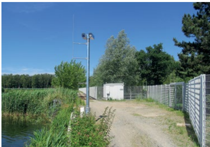
Perimeterabsicherung am Standort Wolfsburg
