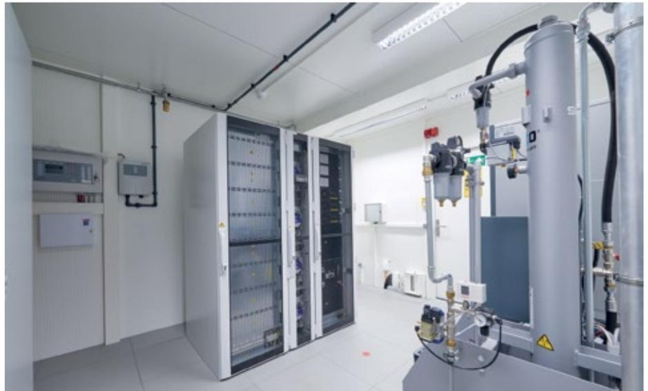
In einem separaten Technikraum innerhalb der Container sind die USV-Systeme untergebracht. Diese sind ebenfalls redundant ausgelegt und sichern den IT-Betrieb bis zu drei Stunden über Batterien
