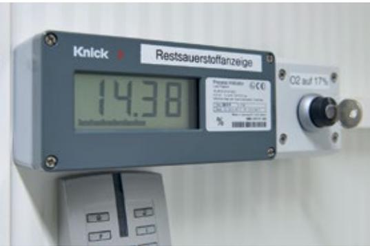
Sauerstoffgehalt unter 14 Prozent: Oxy-Reduct-Anlage sorgt für eine dauerhafte Sauerstoffreduktion der Luft innerhalb des Containers, sodass keine offenen Brände entstehen können – schon bei einer Konzentration von 17 Volumenprozent können Elektronikbauteile nicht mehr Feuer fangen
