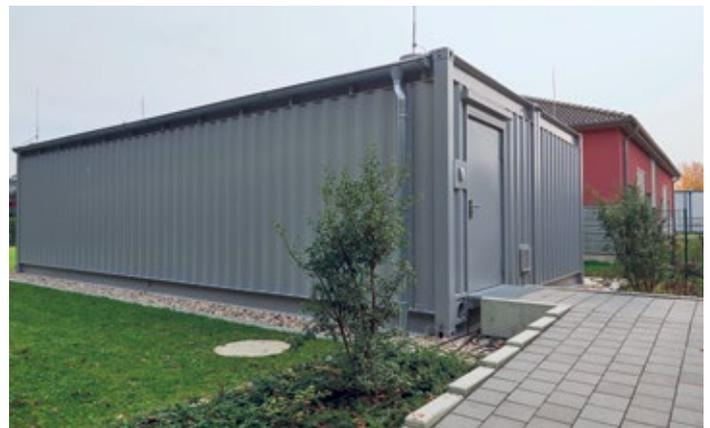
Lösung aus modularen Komponenten: Rechenzentrums-Experten von Rittal konfigurierten auf Basis der von ene't gelieferten Leistungsdaten zwei IT-Container, die die komplette IT beinhalten können und heute auf dem Firmengelände stehen
