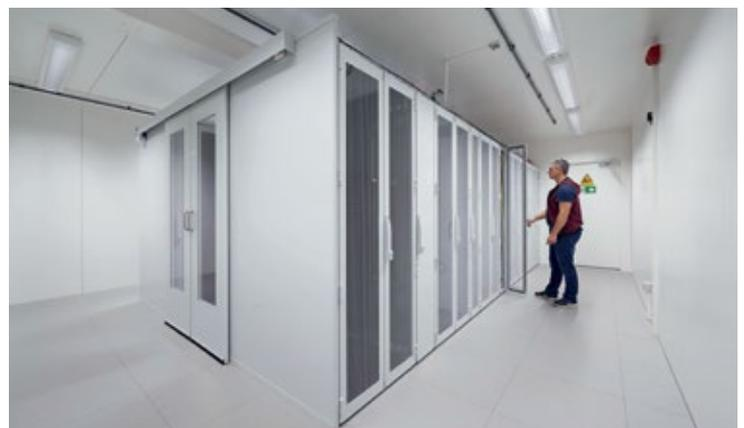
Aufgebaut wie ein modernes Inhouse-Rechenzentrum: Kaltgangeinhausung für IT-Racks ermöglicht die energieeffiziente Klimatisierung der IT-Systeme
