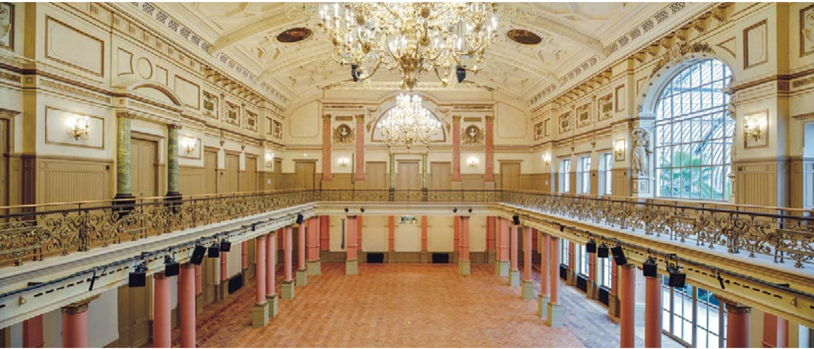
In den meisten Bereichen des Gesellschaftshauses wird mit Feinsprühlöschanlage gearbeitet: übliche Sprinklertechnik hätte historische Stuckarbeiten mit großen Wassermengen zerstören können
