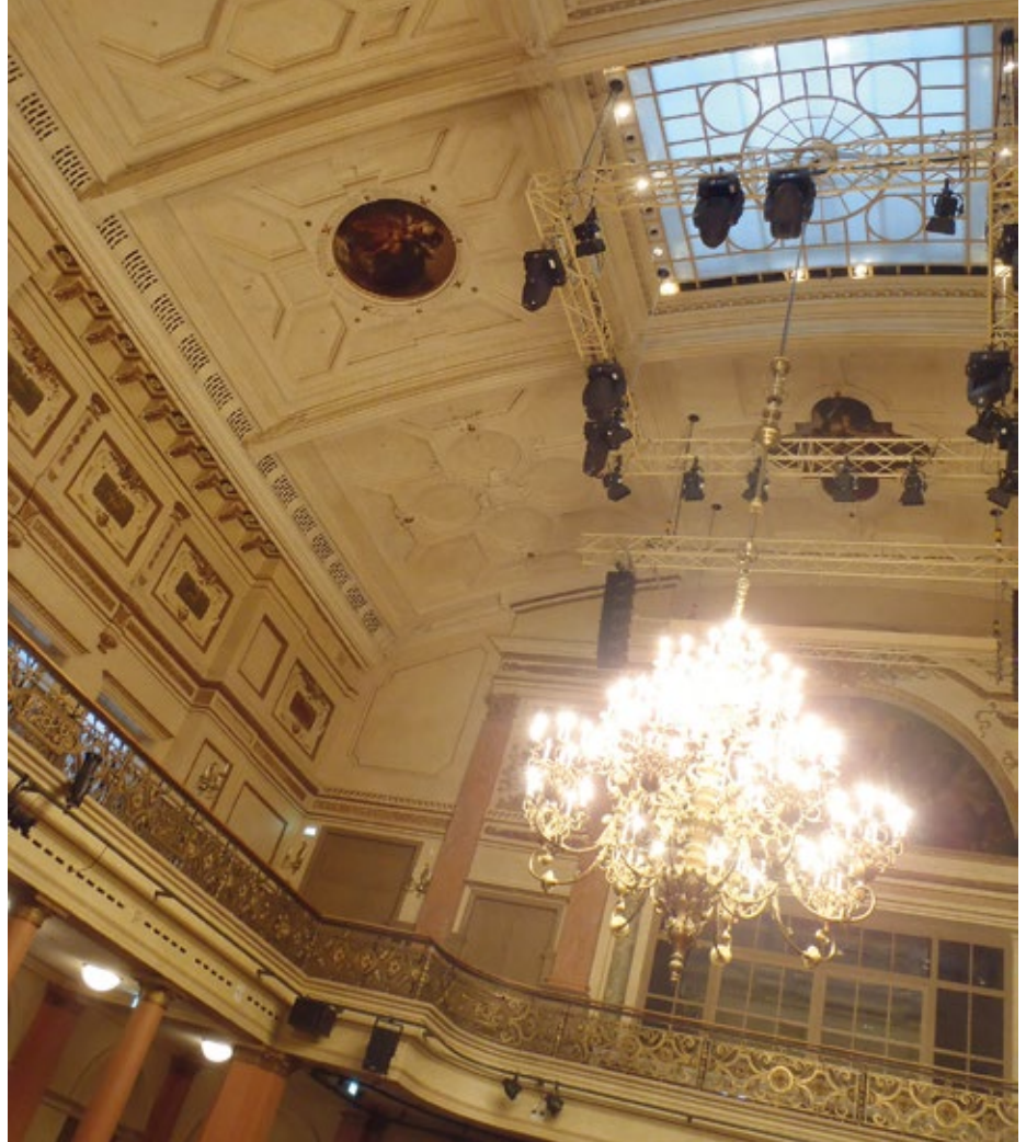
Im Ernstfall kritischster Gebäudeteil des Gesellschaftshauses: den Festsaal im ersten Stock komplett umlaufende Galerie – der fehlende bauliche musste in diesem historischen Bestand durch einen technischen Brandschutz kompensiert werden
