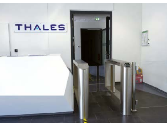
Im Foyer sorgt eine Argus Sensorschleuse für kontrollierten Zutritt
