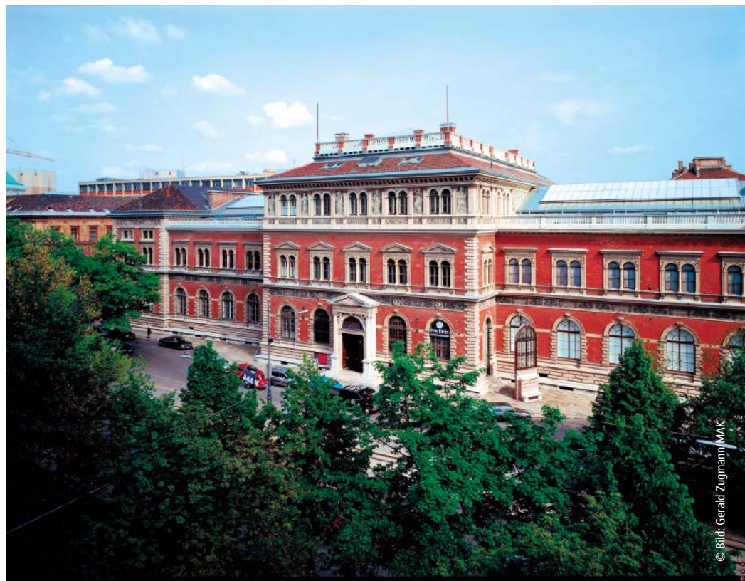
Bei der Modernisierung der Schließanlagen im historischen Hauptstammsitz am Stubenring setzte das MAK auf das eCliq-Schließsystem der Marke Ikon von Assa Abloy
