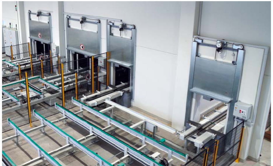
Anlage Brandschutztore, Hörmann KG Werk Leipzig
