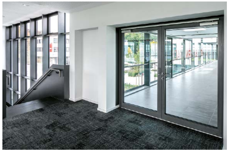
Die Glasbrücke zwischen Akademie und Spielstätte wird beidseitig durch Rauchschutz-Türsysteme von Schüco gesichert
