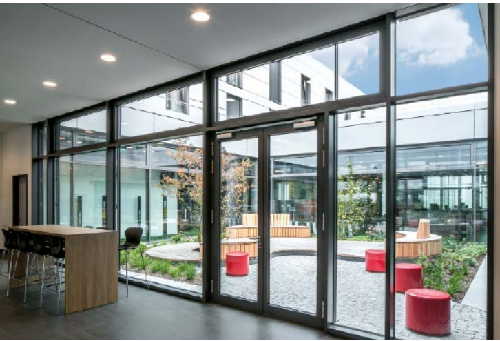
Ausblick auf einen der Innenhöfe mit Türsystem, Fassadensystem und mechanisch-gesteuerten Kippelementen zur natürlichen Entrauchung von Schüco
