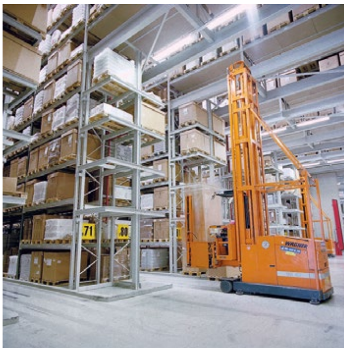
Ansaugrauchmelder im Einsatz in einer hohen Halle, hier Hochregallager ▶
