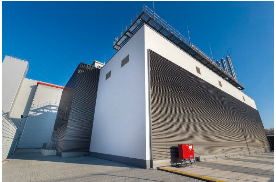
Rechenzentrum von Telehouse Deutschland: Gaslös- und OxyReduct-Sauerstoffreduzierungsanlage – Branddetektion durch Ansaugrauchmelder Titanus
