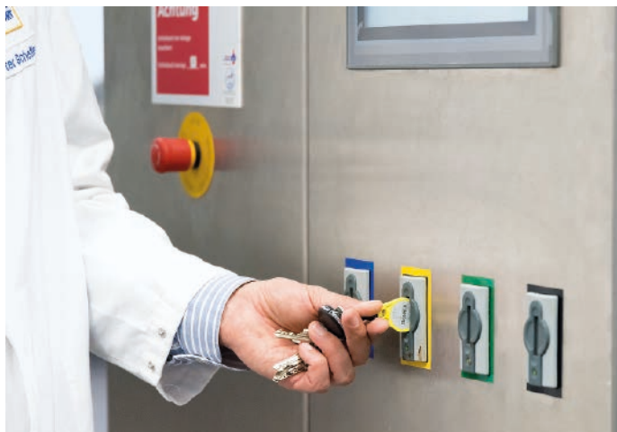
Elektronischer Schlüssel und Schlüsselaufnahme im Einsatz
