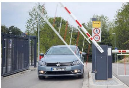
Software Dexicon ist die Kennzeichenerkennung eine Ergänzung der Zutrittskontrolle. Grundsätzlich benötigt werden eine gute Videoüberwachungskamera, eine Videoanalysesoftware und je nach Projektumfang eine Verarbeitungssoftware. Die Stand-alone-Lösung beschränkt sich auf die Kennzeichenerkennung und macht eine Zufahrt der bekannten Fahrzeuge möglich. Erkannt werden europäische Kennzeichen inklusive Türkei und Israel.
