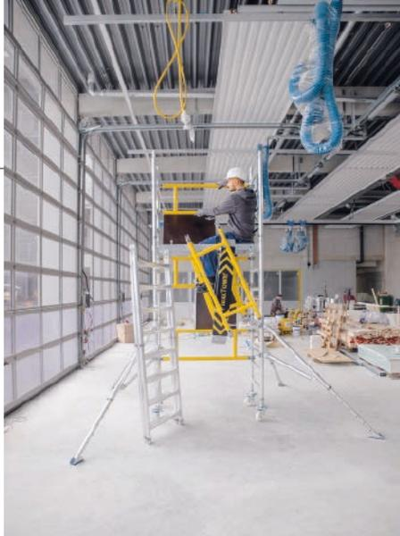
▲ Die Montage ist durch die 3-T-Methode (Through The Trapdoor bedeutet „in der Durchstiegs Luke sitzend“) vorgegeben, sodass sich der Anwender immer im absturzesicherten Bereich befindet
