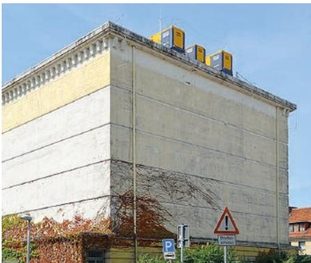
Der Hochbunker mit seinen zwei Meter dicken Wänden aus massivem Stahlbeton schützt das innenliegende Rechenzentrum von ColocationIX vor jeglichen physischen Einflüssen sicher
