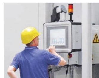
permanente Zustandserfassung ist für Beleuchtung innen und außen, technische Lüftung, Heizung, Türsteuerzentrale, Klimaanlage, Tür und Raumtemperatur möglich.
