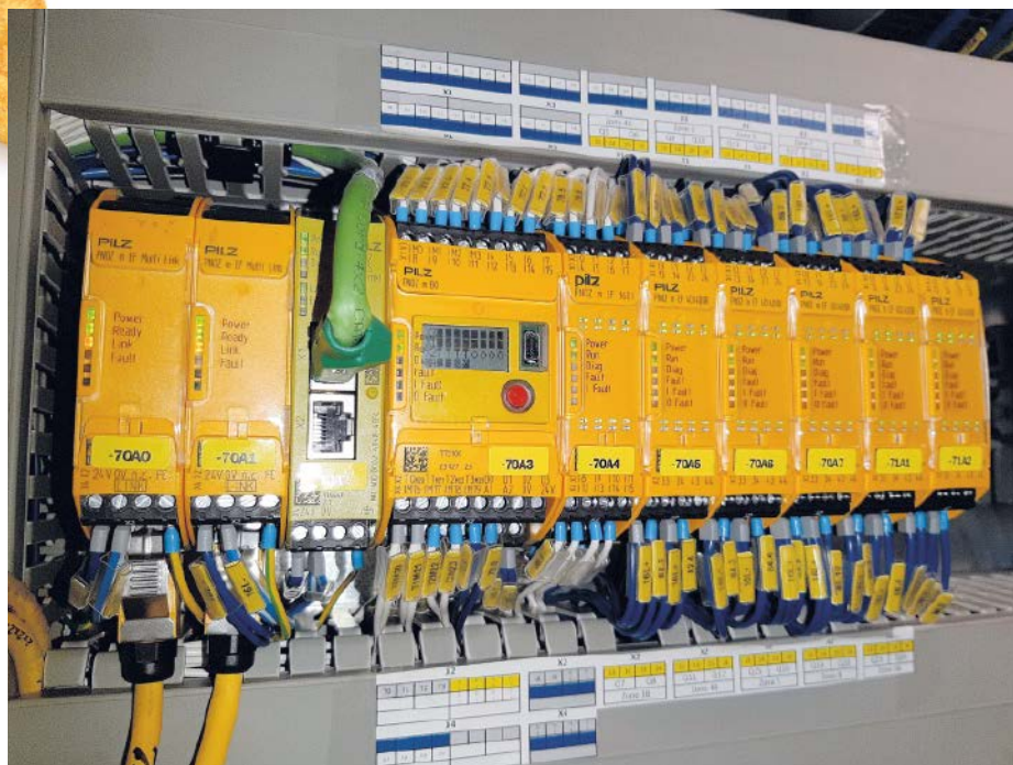
▲ Die Kleinsteuerung PNOZmulti 2 steuert alle Sicherheitsfunktionen
