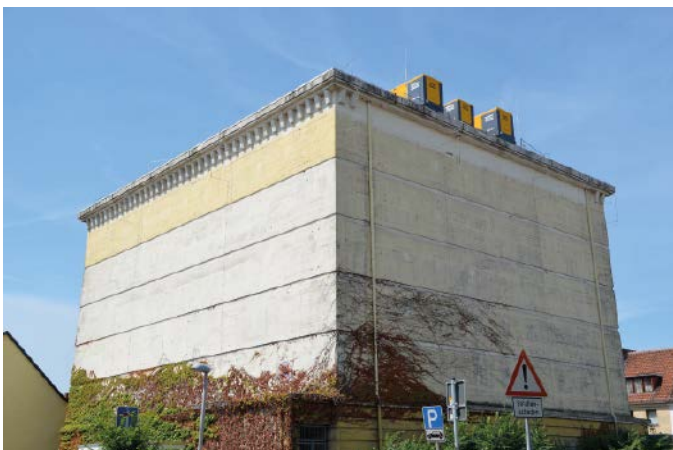
In diesem ehemaligen Atomschutzbunker hat ColocationIX ein Rechenzentrum eingerichtet – mit digitaler Schließtechnik von SimonsVoss
