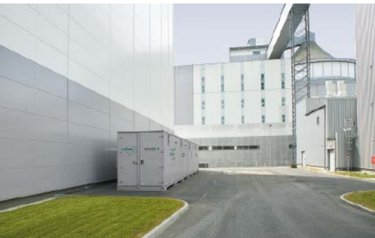
Ein Großteil der Brandschutztechnik wie Stickstoff-erzeuger und Schaltschränke wurden in einem Container neben dem Hochregallager untergebracht
