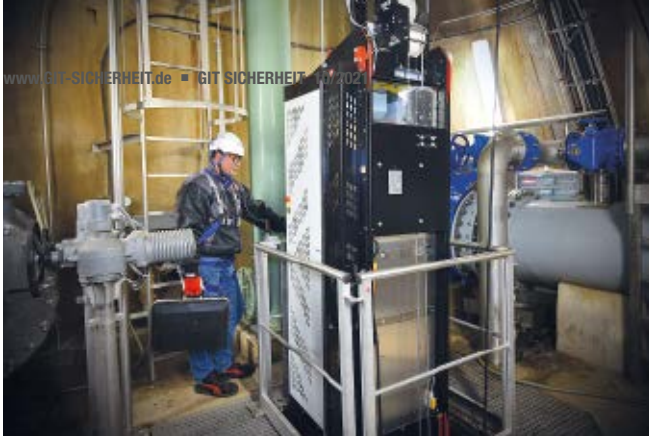
Der seilgeführte Globallift von Hailo in der Talsperre (Trier) in einem Schieberschacht, 50 m tief
