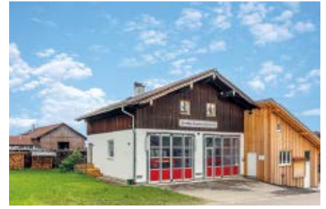
Im Feuerwehrhaus in Ortsteil Herrnhäusen sind die Fahrzeuge und Feuerwehrausrüstung dank eCliq-Schließanlage sicher
