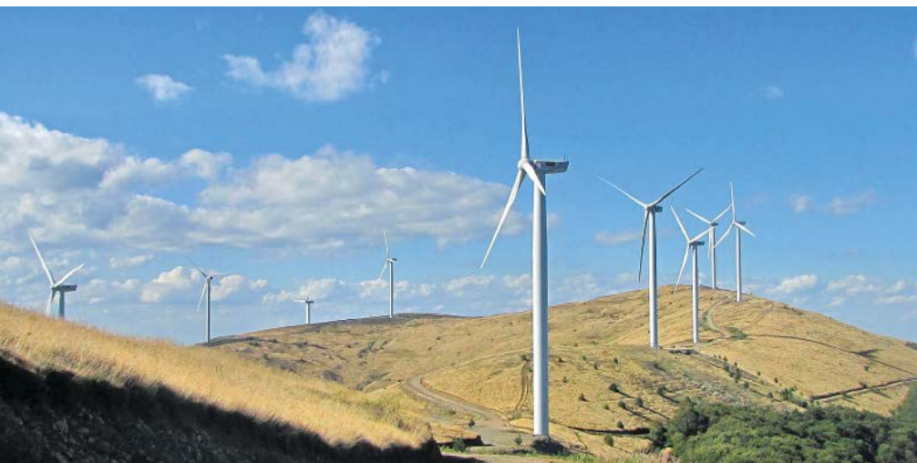
▲ Windpark mit 25 Anlagen des Typs W2E-2.5/100 in Kazanlak (Bulgarien)
