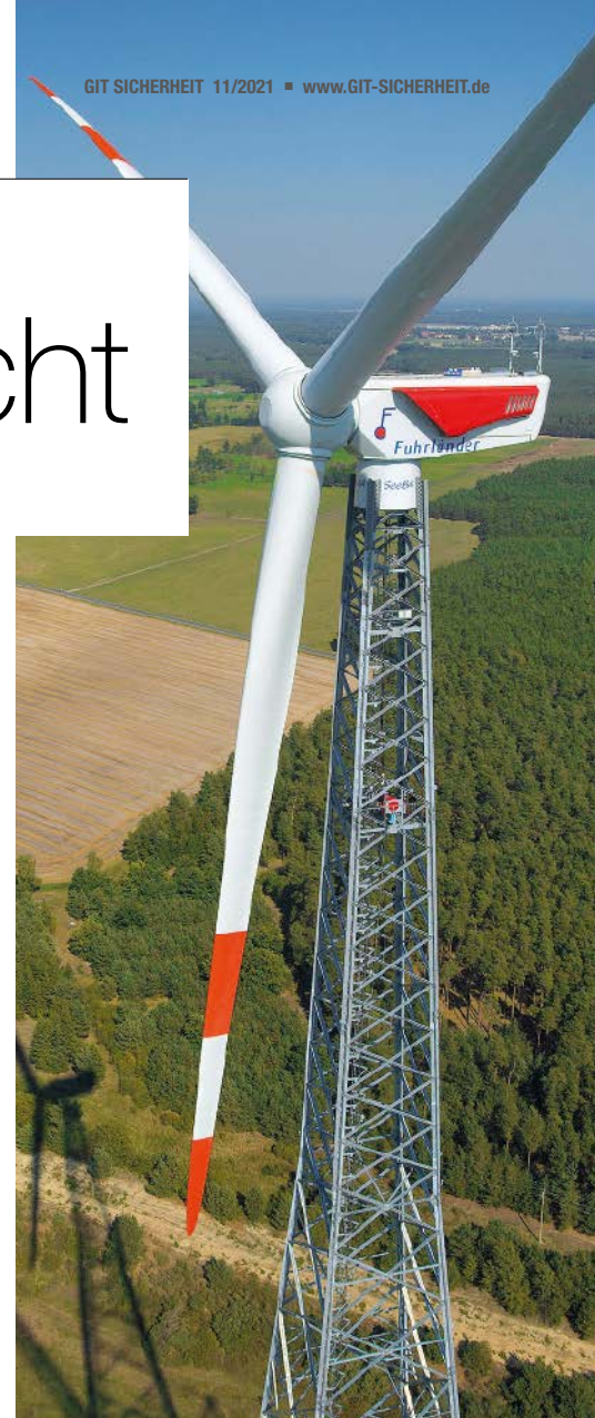
▲ Von W2E geplante Windenergieanlagen sind in den USA, in Europa und in Asien installiert. Die 2006 in Laasow errichtete W2E-2.5/90 war mit einem 160 m hohen Gitterturm für 10 Jahre die höchste Anlage der Welt
