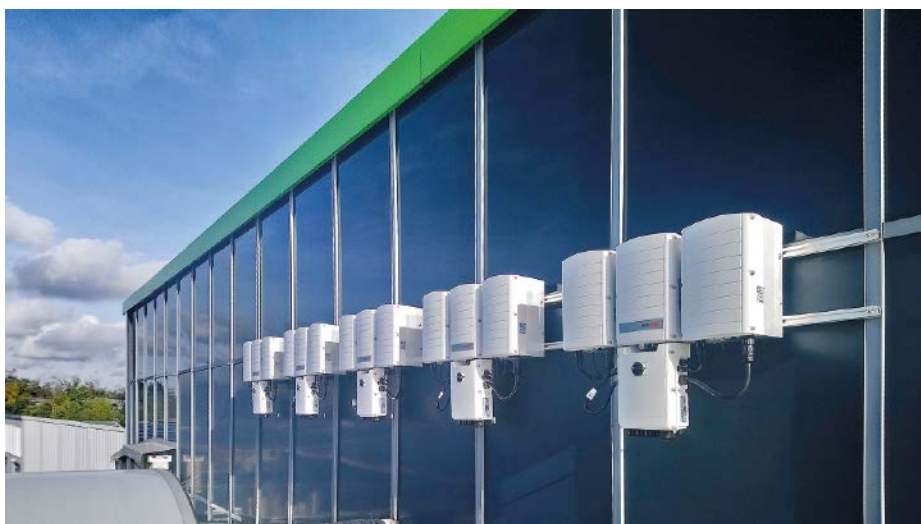
▲ SolarEdge-Leistungsoptimierer und Wechselrichter ermöglichen fortschrittliche Sicherheit der Photovoltaikanlage bei Portawin Kriege
