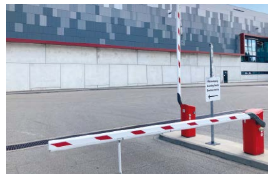
Eine automatische Schrankensteuerung über Weitbereichsleser ist komfortabel und sicher
