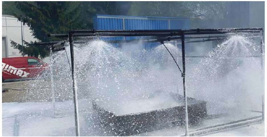
Hier der Versuchsaufbau einer Sprühwasser-Löschanlage mit eingebauten Schwerschaum-Wasserdüsen und Schaummittelzumischung
