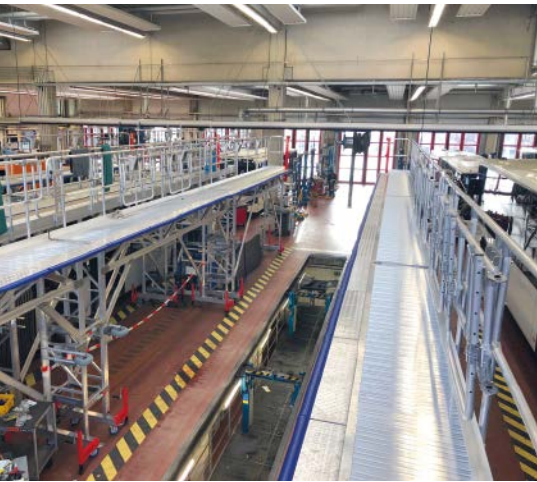
Für die regelmäßigen Wartungsintervalle ihrer E-Busse hat sich die KVB für stationäre Dacharbeitsstände und mobile Plattfortreppen von Zarges entschieden
